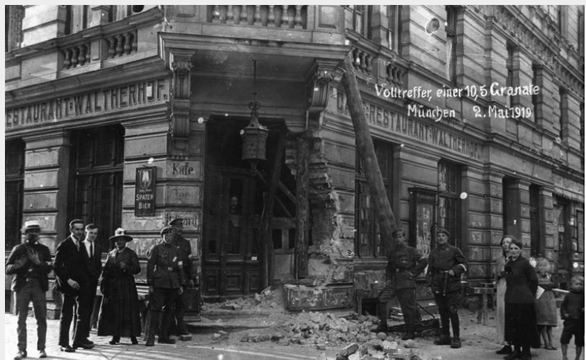
Beschadigde kroeg in München na gevechten, 2 mei 1919.
